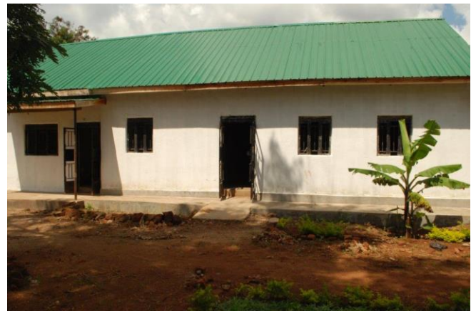
Nieuw dak aangebracht, muren gepleisterd
