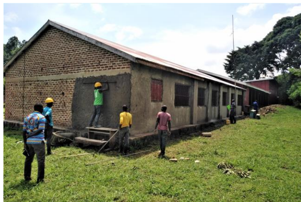
Stucen van de elektrawerkplaats door leerlingen onder begeleiding van een docent
