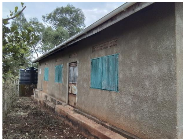
Goten en watertank zijn aangebracht, nu nog schilderen
