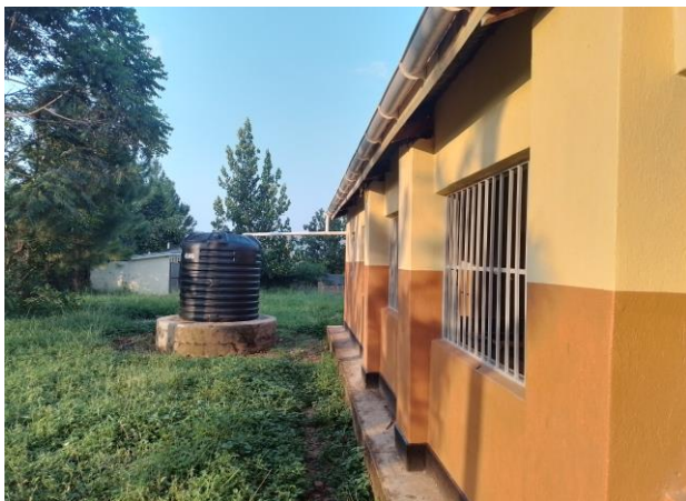
Goten en watertank aangebracht, gebouw geschilderd
