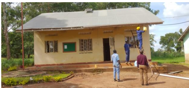
Aanbrengen van goten bij het kantoorgebouw
